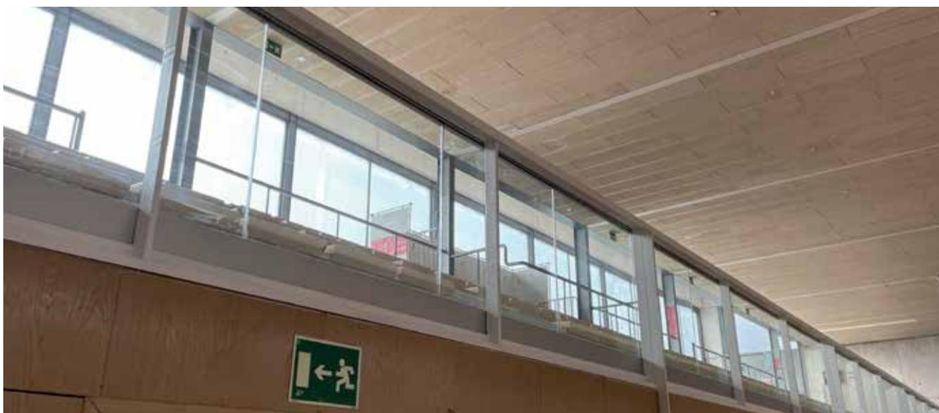
▲ Pabellón Vakxanera. Se ha reparado el pavimento, cambiado la barandilla de gradas por cristal de seguridad y se ha efectuado un tratamiento antitermitas.
