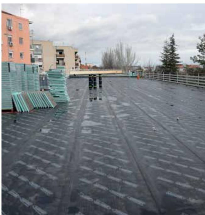
▲ Corrales de Suelta. La actuación consiste en la adecuación del edificio, debido a la necesidad de la reforma de la cubierta por los problemas de filtraciones.
